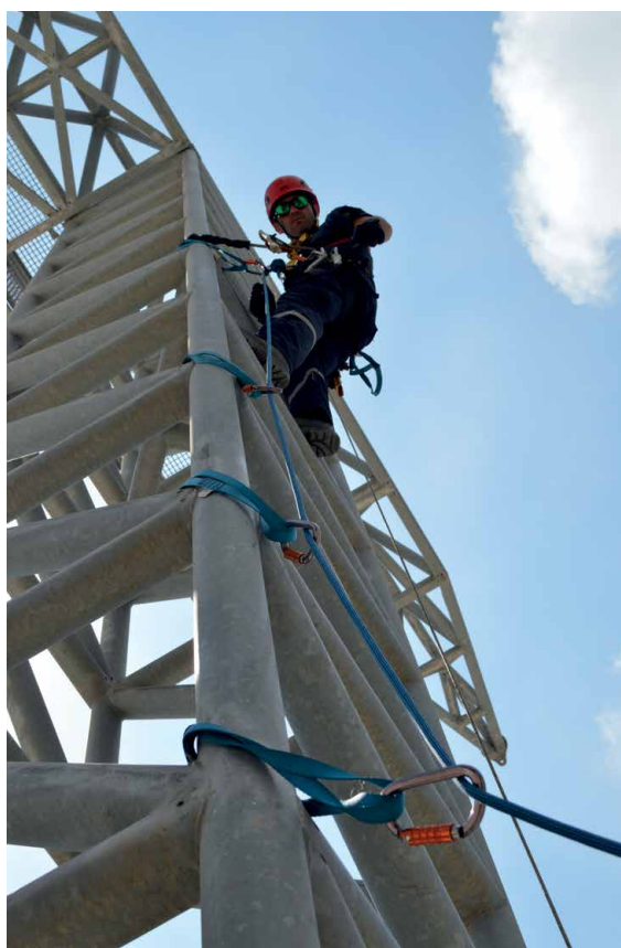
Colocación de distintos seguros intermedios.
