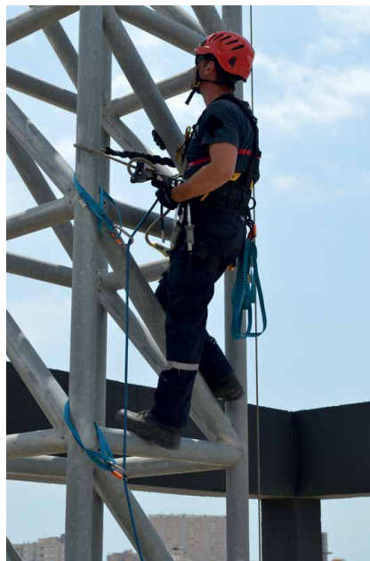
Ejemplo de configuración de elementos para sistema de sujeción
