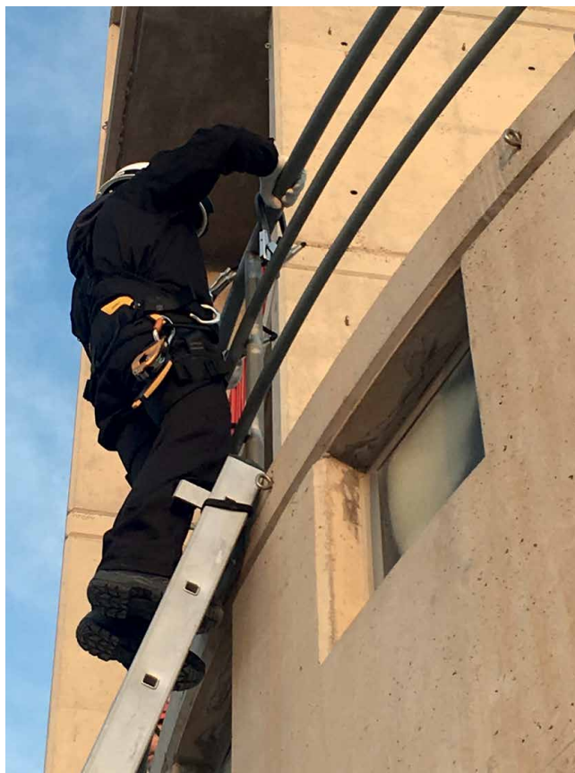
Apoyo en escala manteniendo 3 puntos de apoyo.
