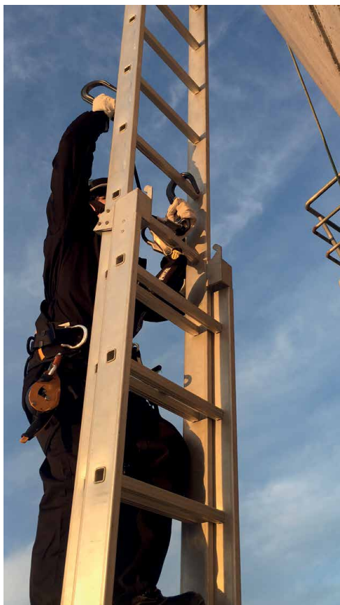
Progresión segura con sistema anticaídas (ganchos MGO + absorbedor).
