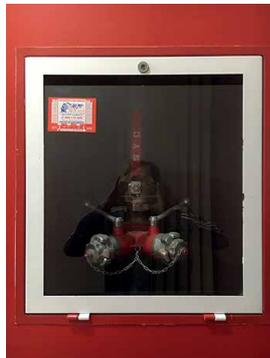
Boca de salida en planta con llave de sección. (Fuente propia).
