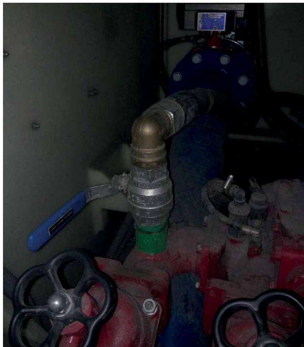
*Válvula de llenado de cisterna, sifón o bypass.*
