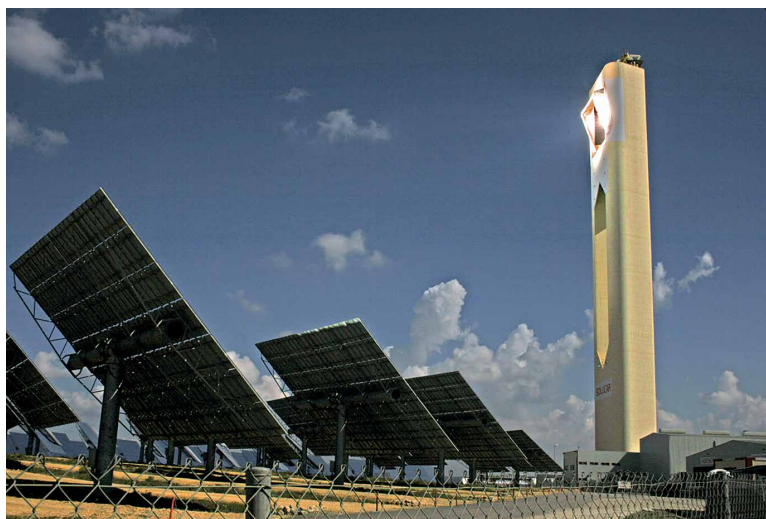
Central termo solar.
