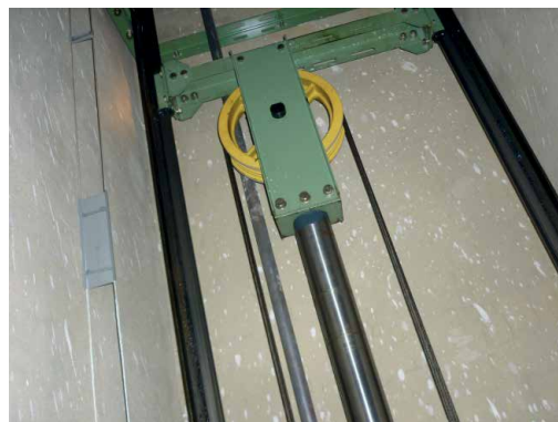
Cilindro hidráulico de tracción indirecta. (Fuente. Propia del autor).
