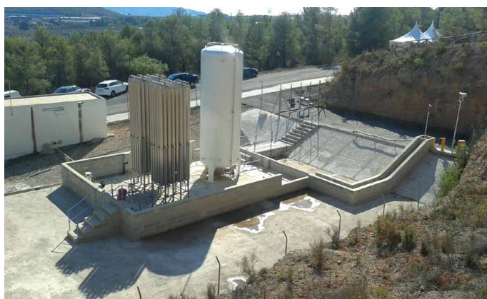
Planta gasificadora autónoma.
