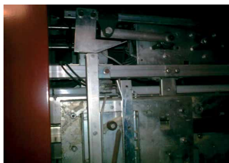
Mecanismo de apertura puerta cabina.
