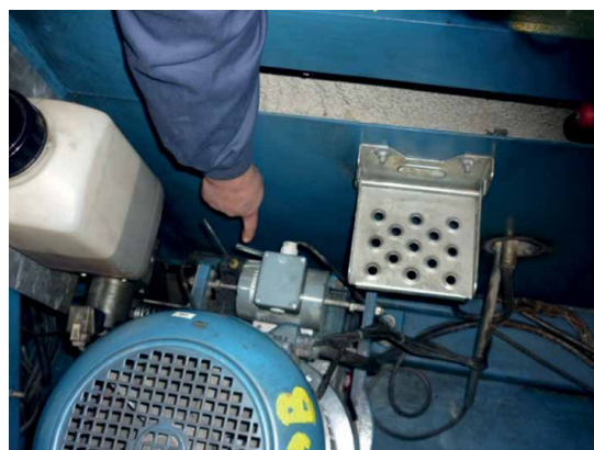
Palanca desbloqueo freno motor.
