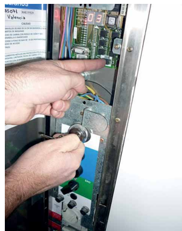
Maniobra manual de emergencia sin sala de máquinas y con botonera.
