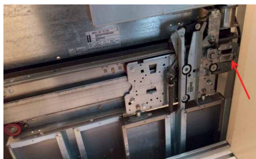
Mecanismo de apertura puerta cabina.
