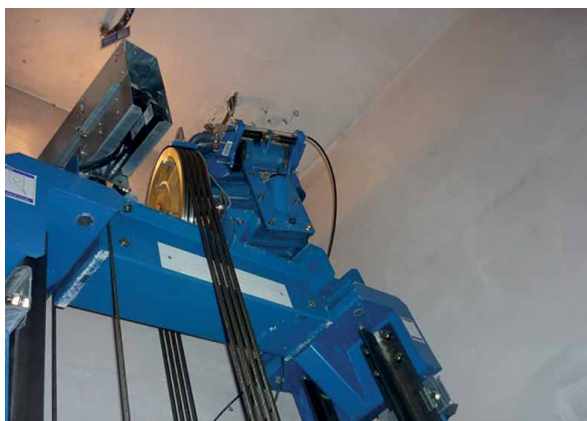
Motor para ascensor sin sala de máquinas.
