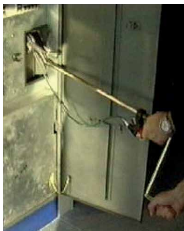
Maniobra manual de emergencia sin sala de máquinas
