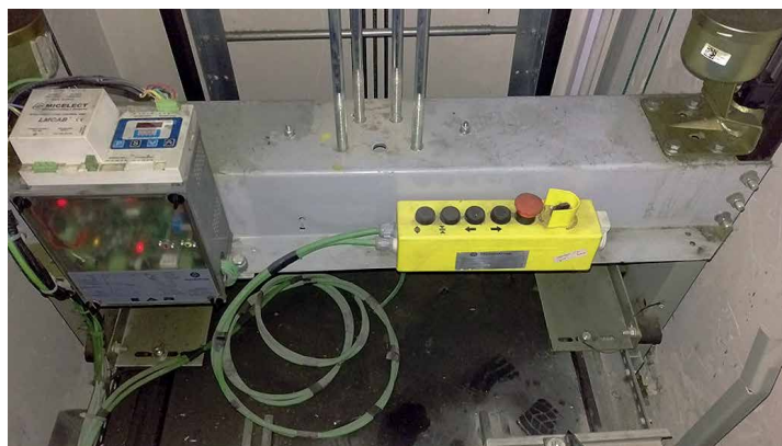
Maniobra de inspección.
